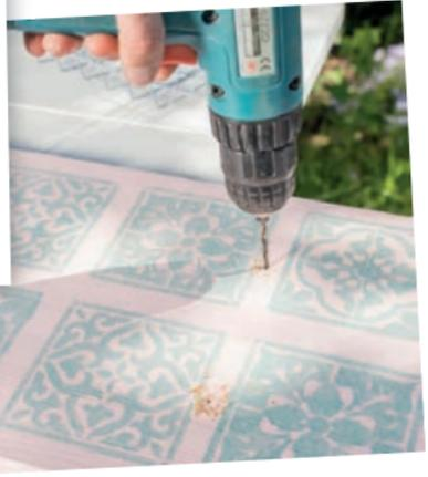
**#2** Mit der Bohrmaschine jeweils zwei Löcher nebeneinander bohren.
